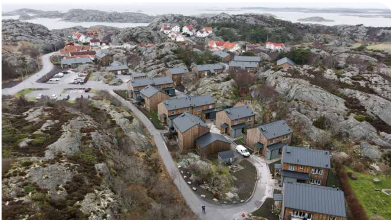
Tjörns Bostads AB:s största byggprojekt under 2022 har varit tak- och fasadbytet på Båsenvägen i Skärhamn. Projektet startade i augusti 2021 och avslutades i december 2022. Foto: Tjörns Bostads AB
